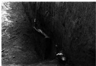
6 Bトレンチ堀輸出状況（東から）
