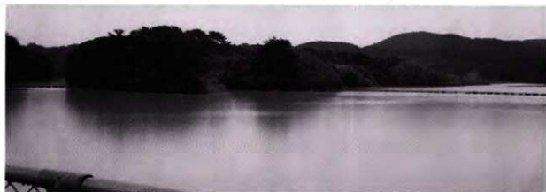
図版27 伊仙町の中部ダム
