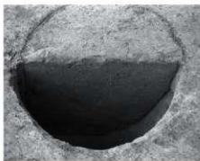
3 9号ビット断面 (南から)
