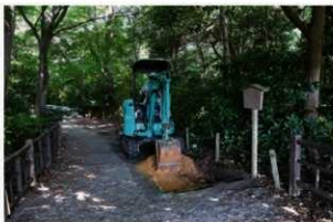
2014-2地点 表土等除去 南東から
