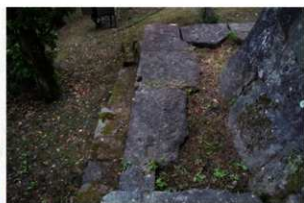
⑤水道石垣中段上面 構造物痕跡 北西から
