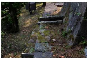
④水道石垣中段上面 構造物痕跡 北西から
