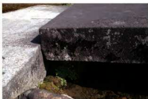
⑤雪見橋 橋板北西側面
