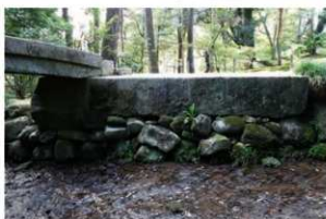
③黄門橋橋台石側面 東から
