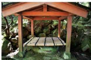
④新清水 全景 西から
