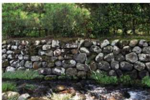
②長谷門付近水路護岸石積 西から
