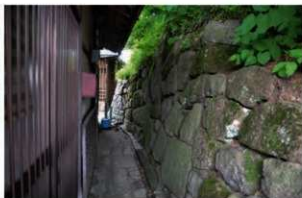
②北辺石垣下段北西部 北西から
