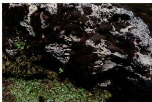
②曲水西北部 護岸 (木葉石) 近景
