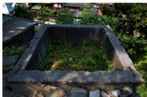
④水道屈曲部 樹 (大樹) 南から
