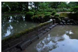
①瓢池北東部南側間仕切り 東から
