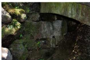
⑤黄門橋橋台石積 北西から
