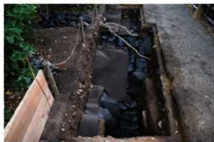
埋め戻し作業 (遺構養生)
