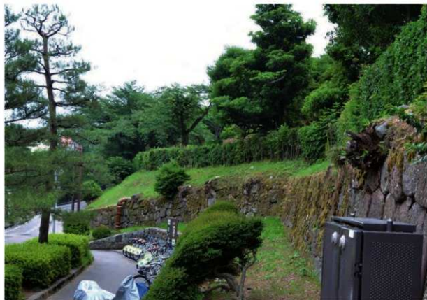
①北辺石垣C・D面 遠景 北西から
