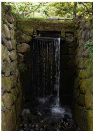
⑦瓢池排水路 滝状部 西から
