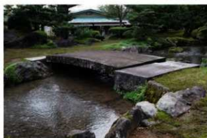
④雪見橋 全景 西から
