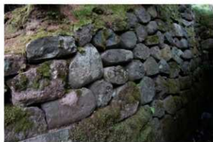
①瓢池排水路 石積 南西から
