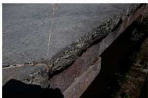
⑤日暮橋橋板側面
