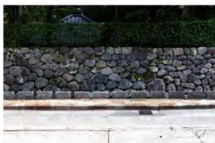
⑤南東部石積 南西から
