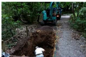
2014-1地点 表土等除去 北から
