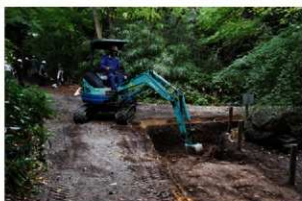
埋め戻し作業
