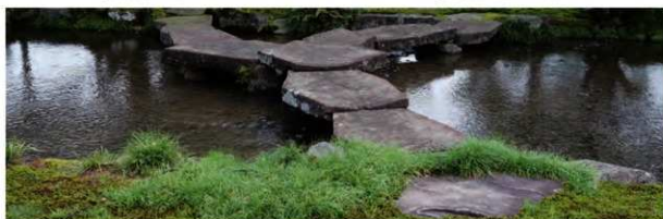
⑥雁行橋（亀甲橋） 全景 南西から
