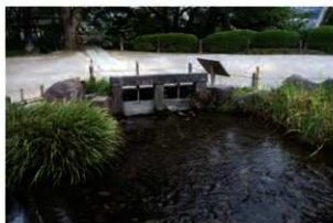
①取水口 南から
