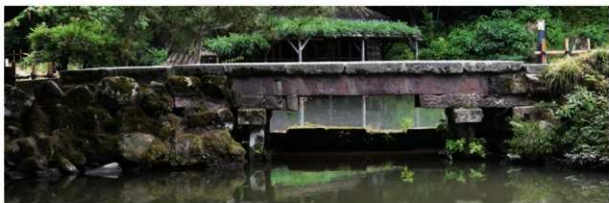
①日暮橋 全景 西から
