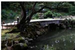
②日暮橋 全景 北西から
