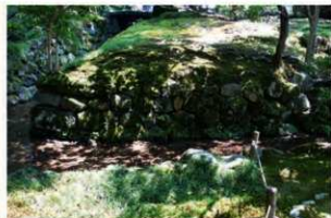
②水路護岸石積（栄蝶橋南） 南西から
