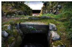
③西辺塀基礎（瓢池排水路上部） 東から
