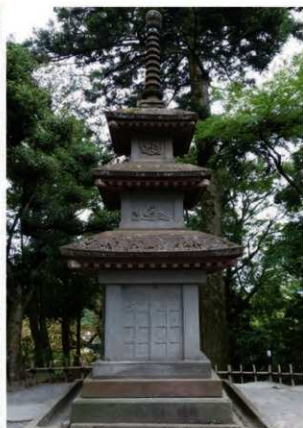
② 榮螺山石塔 北西から
