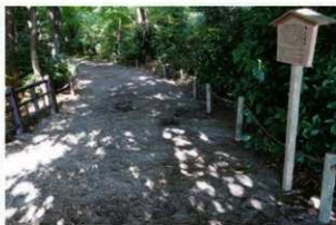
埋め戻し完了状況
