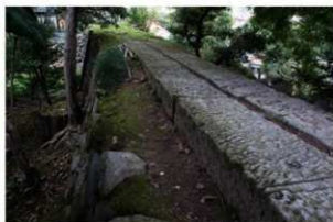
②水道 (辰巳用水石管) 南から
