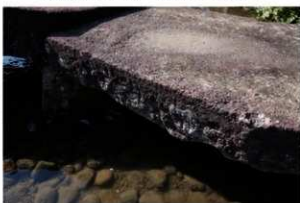
④雁行橋（亀甲橋） 橋板側面 東から
