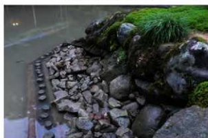
⑤瓢池中央中島 護岸・景石 西から
