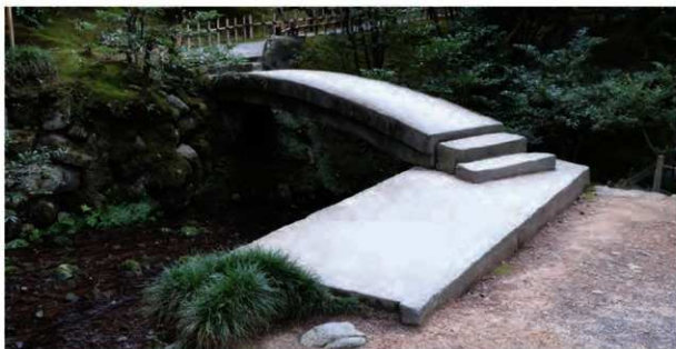
①黄門橋全景 北西から
