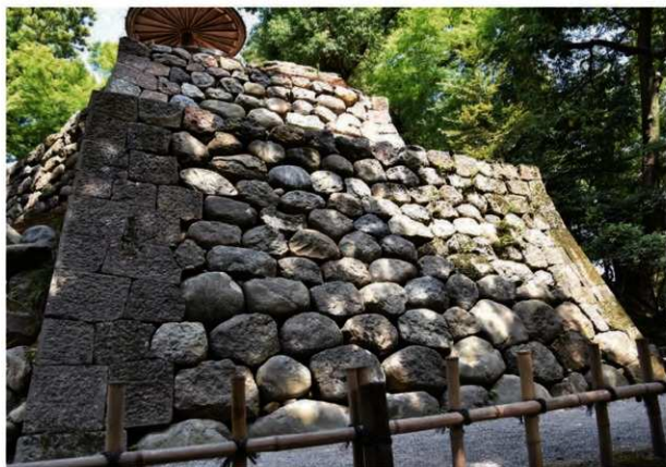
①栄螺山石垣南西面（石垣1）修復後
