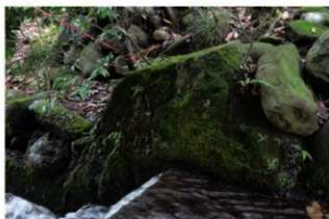
②翠滝上流護岸石北側 南から
