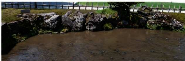
③曲水西北部 護岸 北東から
