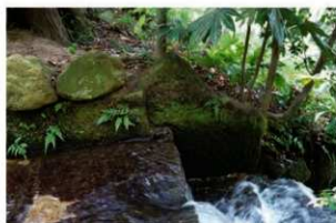
③翠滝上流護岸石南側 北から
