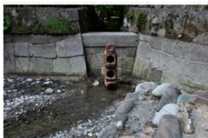
③露池護岸石垣【竹沢庭】
