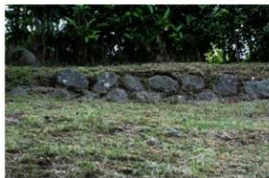
⑤北辺土塀基礎（石壇F面上） 北東から
