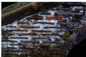
②圓月橋 東端部近景
