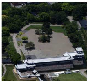
第33図 ニノ丸の現況 東から
