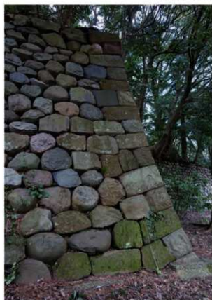
②石垣DE面間出角 南西から
