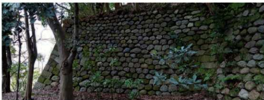
①石垣D面 南東から
