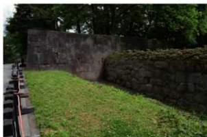
① 雑土蔵下 (2710W)・数寄屋屋敷北 (2800N) 北西から
