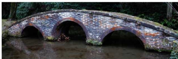
⑦圓月橋 北から
