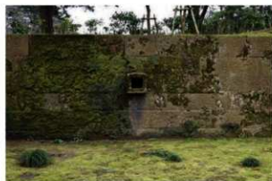
①数寄屋敷敷東石垣 石垣（北部）西から
