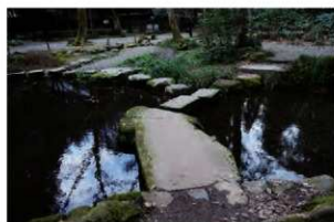
①琵琶島東端石橋 南西から
