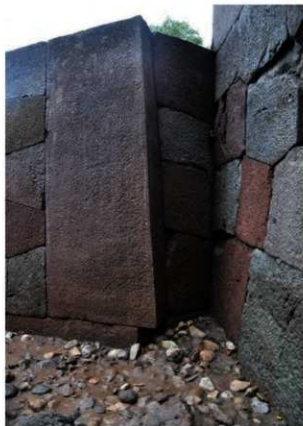
③色紙短冊積石垣西 (2670E-2640S接続部) 南東から
