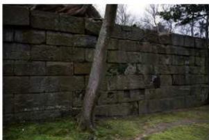
⑤ 数寄屋屋敷東石垣 (2720W) 南部 西から
