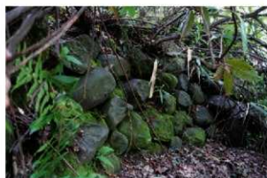
③刎橋跡 池西岸取付部 南東から
