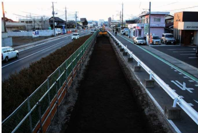
▲第1面(浅間B軽石層)下面全景 (遺跡東半部, 東から, 写真上方が高崎駅東口)
