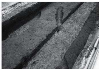
3号溝全景(南西から)
