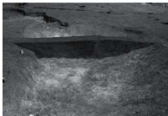
33号溝断面C-C'（南西から）
