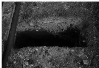
新田堀の築堤のトレンチ土層断面 (C-C') (北西から)
