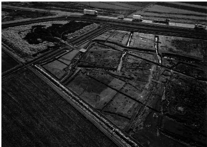
第1溝状遺構全景（左残土置き場が上強戸遺跡群Ⅱ区調査区）（北西から）
