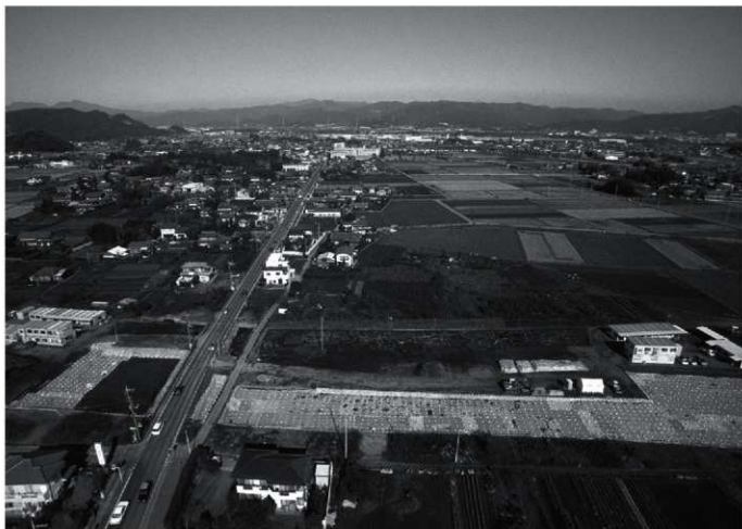
1・2区北部全景（南から）
