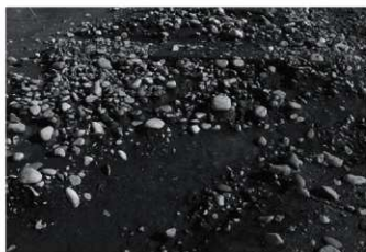
IV区盛土調査状況E地区(西)
