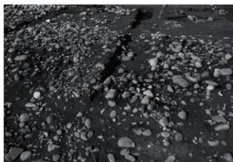
IV区盛土調査状況D地区(南東)
