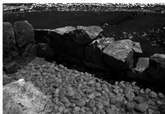
1号墳 玄室東壁構築状況
