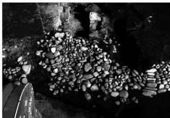
7号墳 前底部石垣崩落状況
