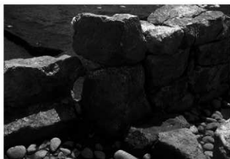
1号墳 玄門東側構築状況
