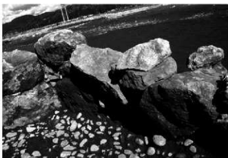
3号墳 玄室東壁構築状況
