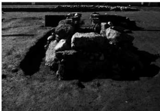
3号墳 石室構築状況(北から)
