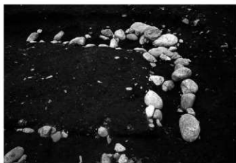
1号墳 石室根石栗石設置状況
