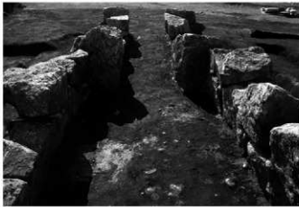
4号墳 石室構築状況
