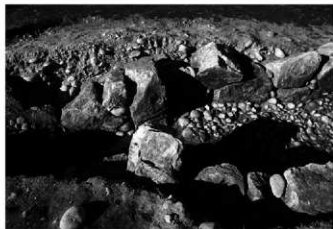
4号墳 玄門と西壁構築状況
