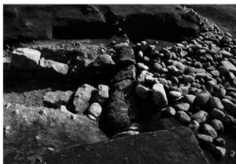
7号墳 前底部石垣崩落状況
