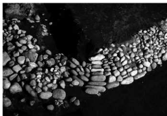
7号墳 前底部石垣崩落状況
