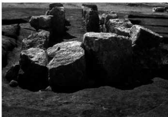
4号墳 石室構築状況(北から)
