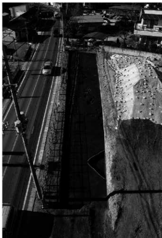
2. A区西側全景(東から)
