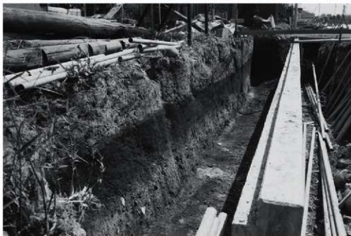
2 調査状況と土層断面－前方部 (西から)
