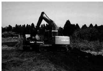
6. 埋め戻し作業
