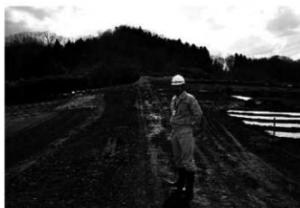
7. 埋め戻し完了状況
