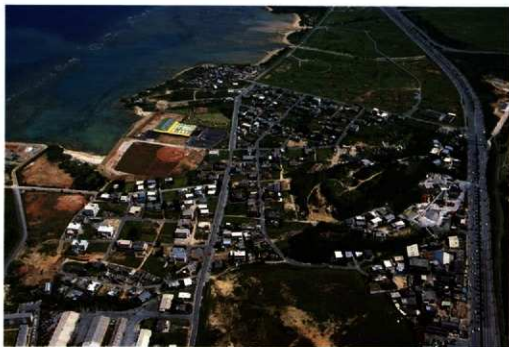
史跡の多い砂辺地区の航空写真（南側より）
