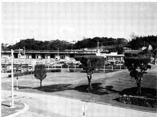
上 遺跡遠景（南東側より）
