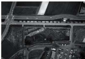
5区全景（真上から・上が北東）
