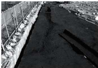
Ⅲ区8号溝全景 (西)
