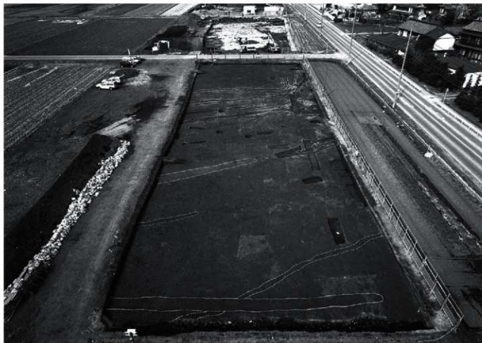
V区調査区全景（南東）
