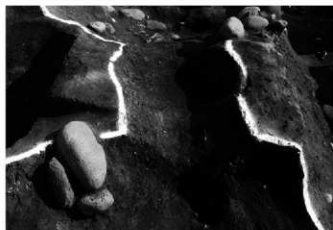
(5) 2号製鉄炉 炉体
