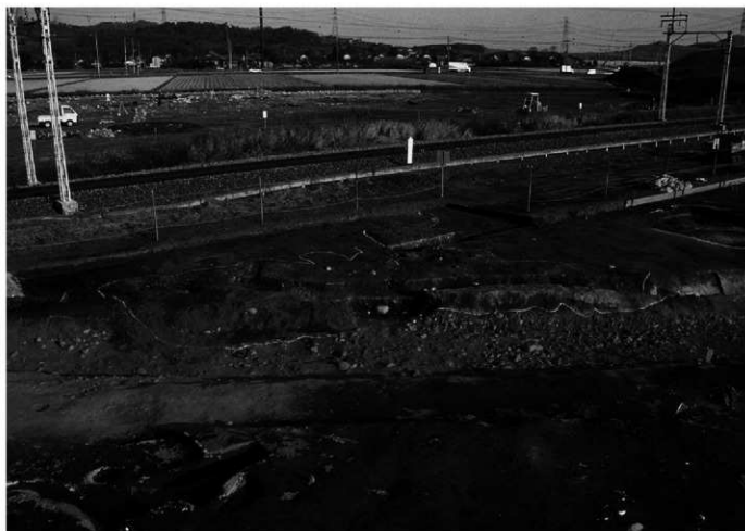
(5) 製鉄道構プラン確認全景
