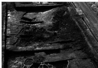
(7)-2 排水場 1・2群全景
