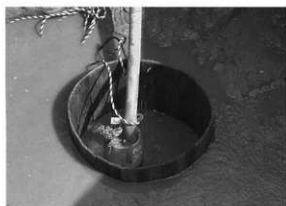
SE017 桶側4段目検出状況
