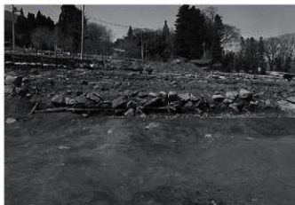
5 20区16号石垣 近接 (東から)
