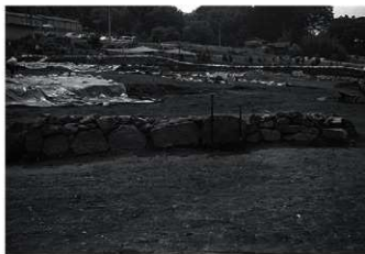
2 20区10号石垣 全景（東から）
