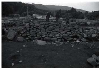
2 20区15号石垣 近接 (東から)
