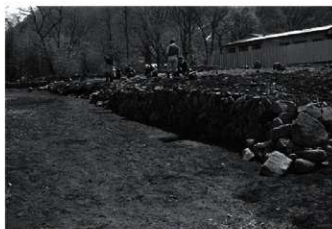
4 18区1号石垣 (北西から)
