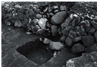
1 18区1号石垣 C~C'セクション (西から)
