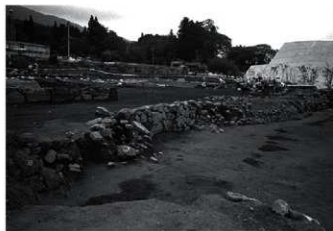
5 20区13号石垣 全景 (東から)
