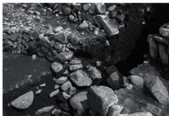
8 18区1・2号石垣 A~A'セクション (西から)
