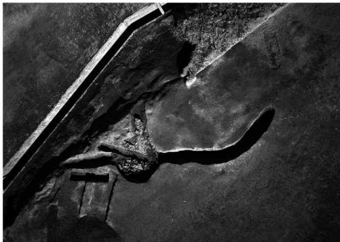
1区1号製鉄炉 全景（上空より。中央の円形土坑が排滓坑。円形土坑の上が炉体、右の溝が固溝、左の溝が排滓溝。）
