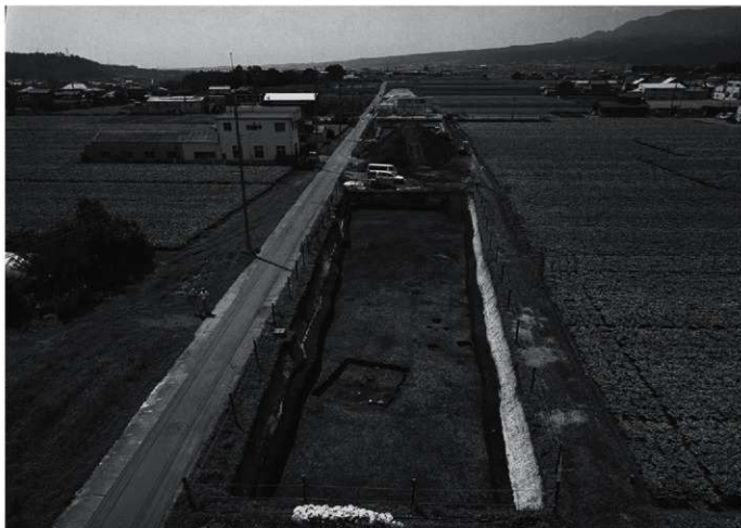
3区 調査区全景（北より）
