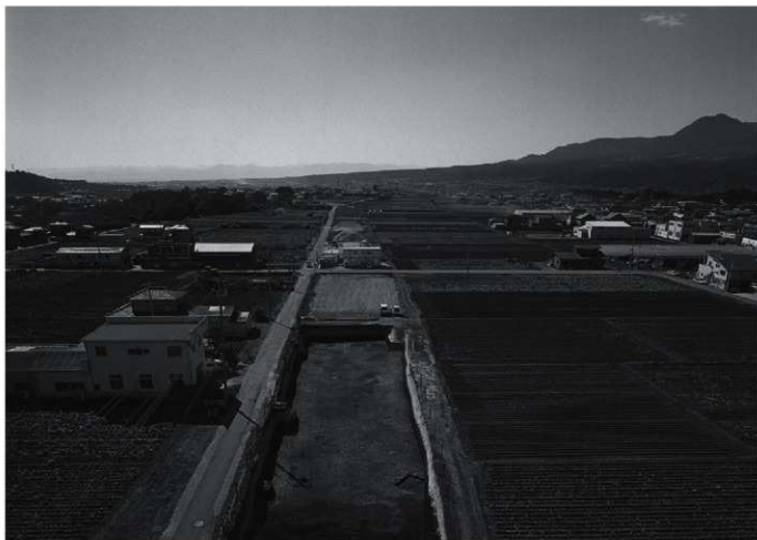
2区 調査区全景（北より）
