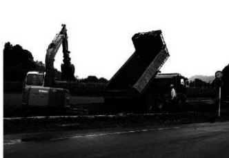
5. 埋め戻し作業状況(北西から)
