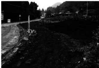
6. 調査完了状況(南から)
