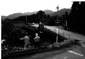
1. 表土掘削作業状況(北から)
