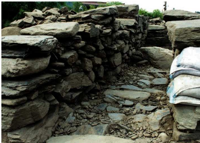
2 原古墳、横穴式石室石積み状況
