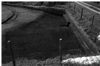
1. 2区第5洪水層下面全景(北から)
