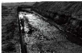
3. 女堀荒口地区前田2区の調査(南から)
