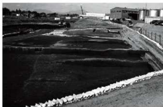
5. 4区女堀排土土層断面(南東から)
