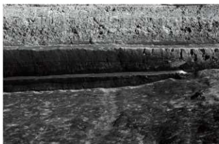
4. 1区As-B下面東壁土層断面A-A'南部(西から)
