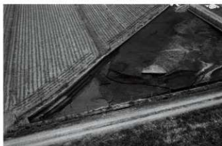
7. 3区女堀排土下面全景(北西から)
