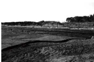
5. 4区西壁土層断面 (南東から)
