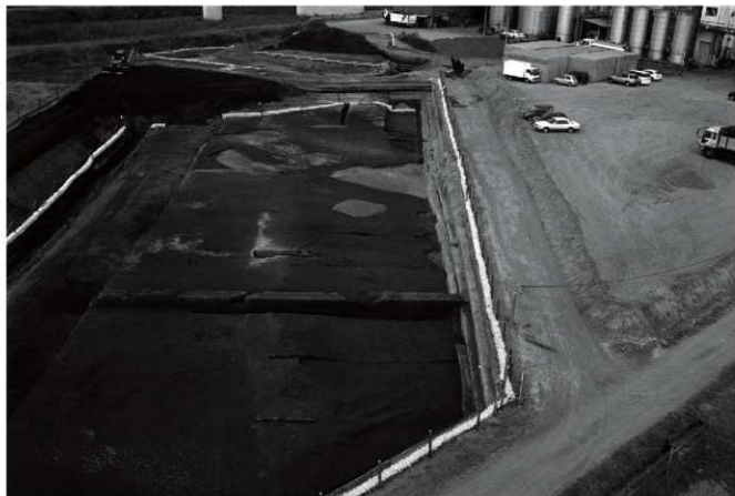
3. 4区女堀排土下面全景(南東から)
