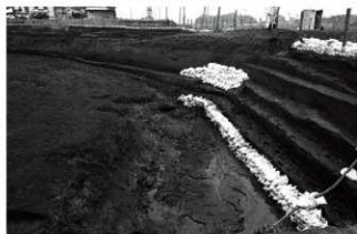
7. 4区As-B南端低地部(北から)
