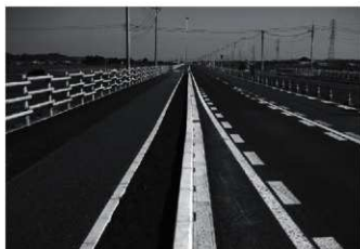
工事完了後風景 (西から)
