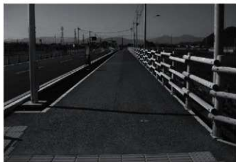
工事完了後風景(東から)
