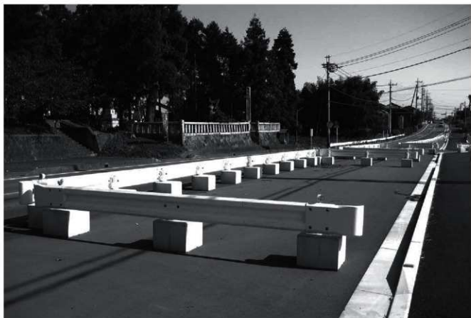
工事完成後(西から)
