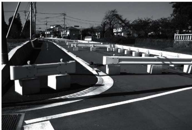
工事完成後(東から)
