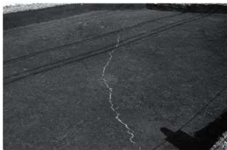
噴砂確認状況（2区中・北部、東より）
