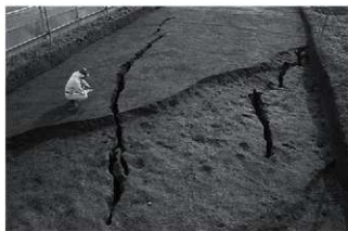
2区地割痕（北より）
