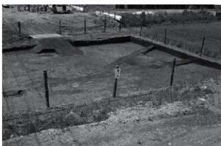
6区北部遺構確認状況（北より）
