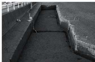
As-C 混土下水田 (6区張出し、東より)
