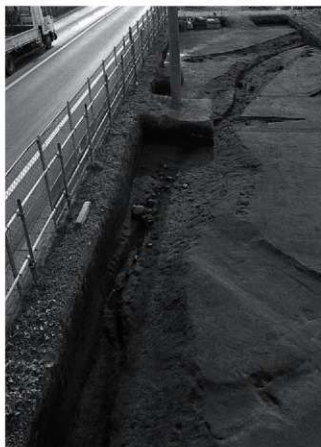
7～10号溝全景 (北より)
