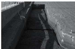
As-C 混土下面 (6区張出し、東より)
