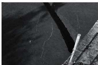
噴砂痕（2区、南より）
