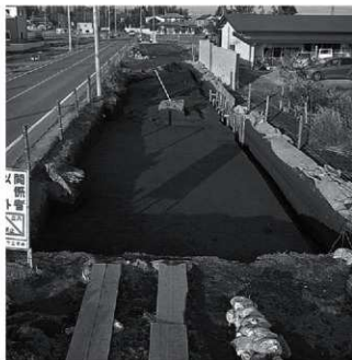
2面全景（1区、南より）
