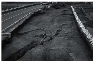
1区北半部全景 (南より)
