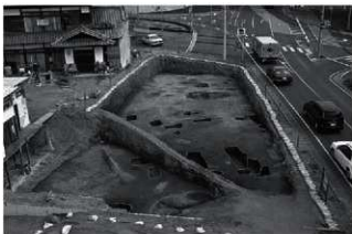
7区北部全景（南より）（向こう側は上武道路との立体交差）
