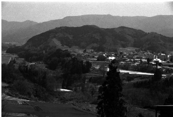
道跡地遠景 西から
