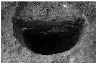
F区1号掘立柱建物柱穴P2土層断面 南から
