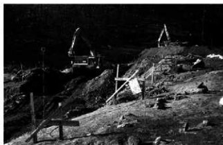
85区埋め戻し作業風景（東から）
