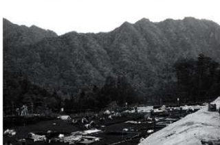
作業風景 (北から)
