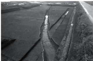
4区7号溝跡全景(北)
