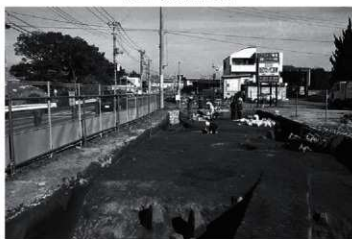
A区 作業風景(南から)
