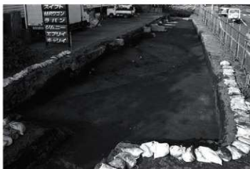
D区 2号墳全景 (南から)
