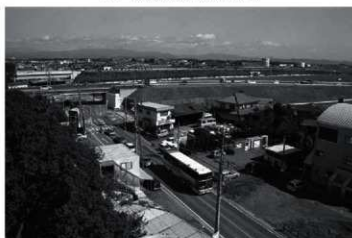
A区 遠景(南から)
