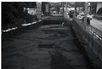
D区 旧石器試掘トレンチ配置状況(南から)
