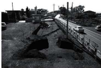
A区 遠景(北から)
