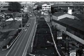
B区 遠景 (南から)
