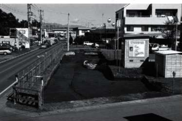
A区 遠景(南から)
