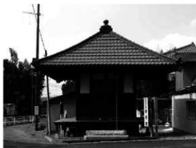
【参考】金井姥子堂(江戸後期・甘栗町) 時期・構造から1号基礎建物に近似する遺例と考えられる。(屋根は葺き替えられている。)
