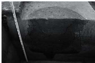
23号土坑土層（フラスコ状、底面近くに黒色土。南から）
