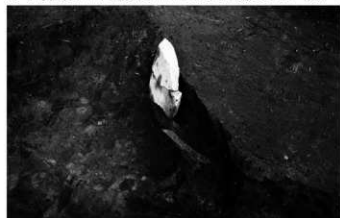
7 2号住居カマド右袖側土台の切石と上に乗った内壁の切石 南西→
