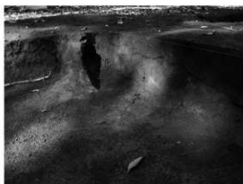
カマド部分土層断面
