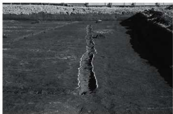
1 2 a区第3面3号溝(西から)
