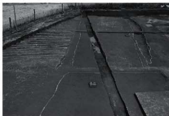
1 3区第2面水田・第1面畠復旧溝(西から)
