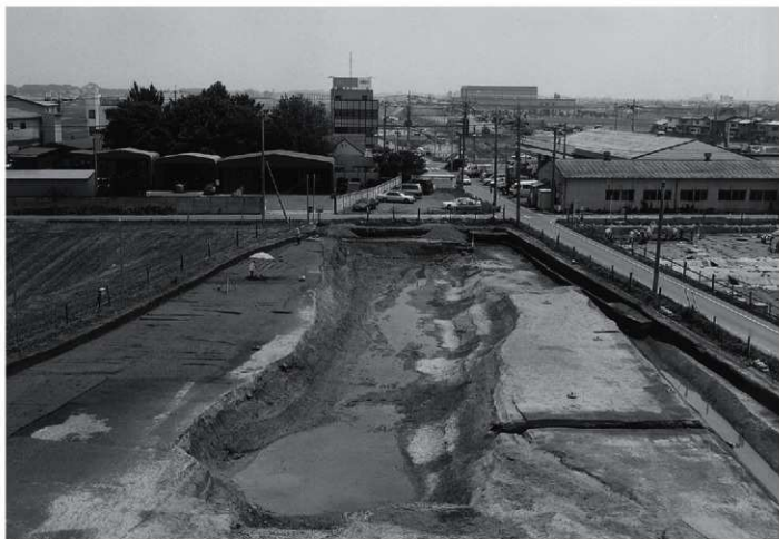
1 3区第5面用水路(西から)
