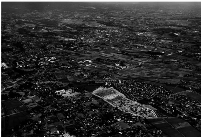
1 上武道路予定地を南西上空から望む
