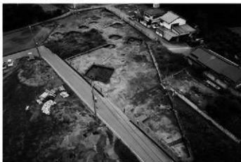
4 3区全景 北西上空
