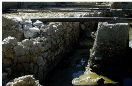
平成18年度 検出された石列遺構⑦近景。
