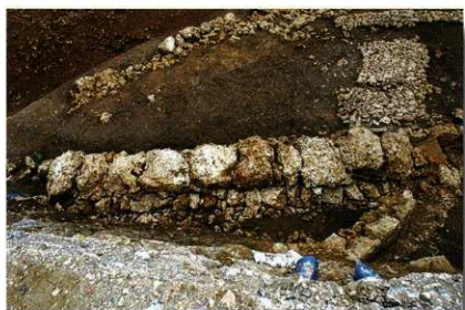
2区 排水溝 7 暗渠蓋石検出状況
