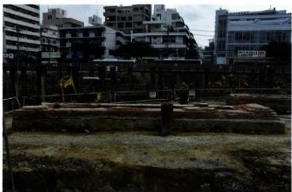
2号遺構 南西より コンクリート基礎の上にレンガを積んでいる。
