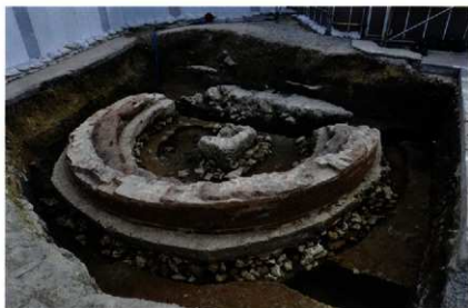
転車台（俯瞰）北西より レンガ積みは2段構造になっている。
