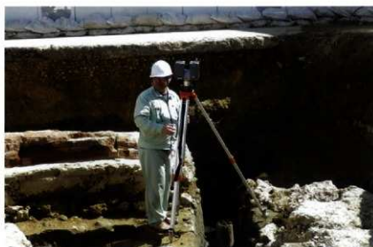
三次元レーザー測量
