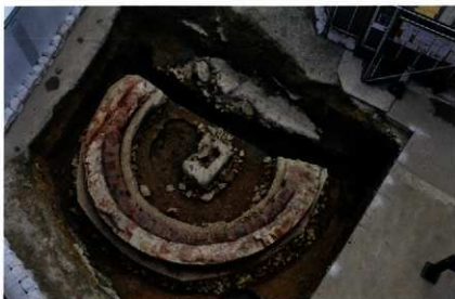
転車台（俯瞰）北西より ドーナツ状のコンクリート基礎とレンガ積み、中央には回転軸。
