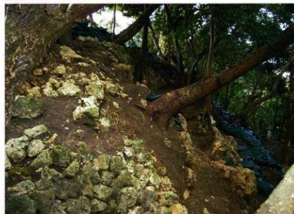
築山後方斜面の土留め石積み
