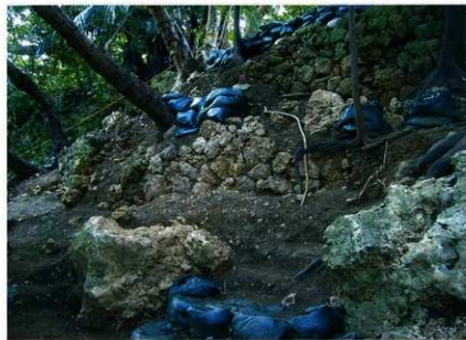
築山後方斜面の土留め石積み
