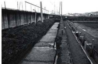
6 E区3面 全景 (西から)
