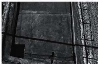
7 N区 全景 (西から)
