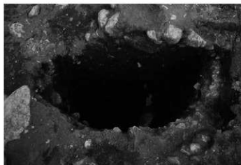
8 同7 柱6 柱痕確認状況
