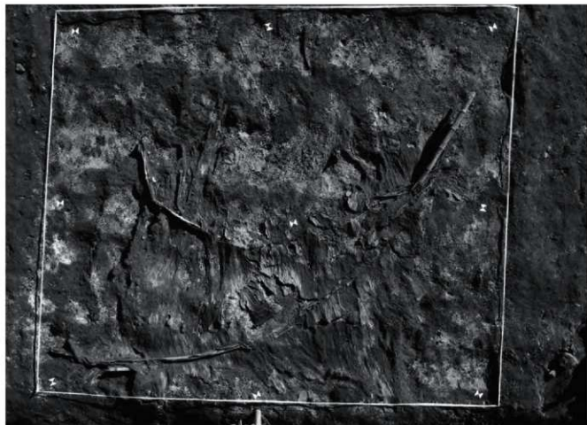
屋根材全景 (上方が東)
