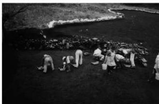
1号石垣作業風景（南から）
