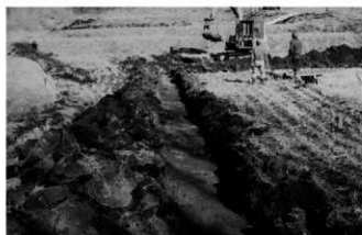
試掘Aトレンチ（南から）
