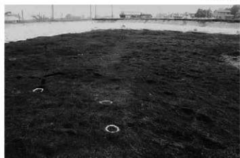
Fブロック全景 北から
