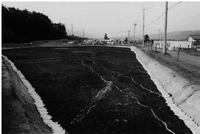
Dブロック全景 南西から
