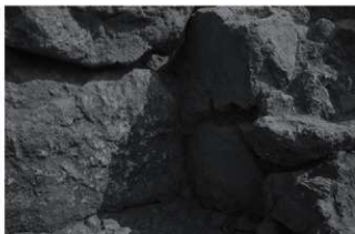
3 2号墳 石室 奥壁と東側壁の接合状況 (南西→)
