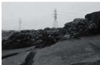
5 2号墳 石室東側壁 石積み背面状況 (東→)
